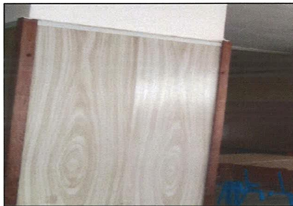
Снимка 22 – PVC облицовка в столова
