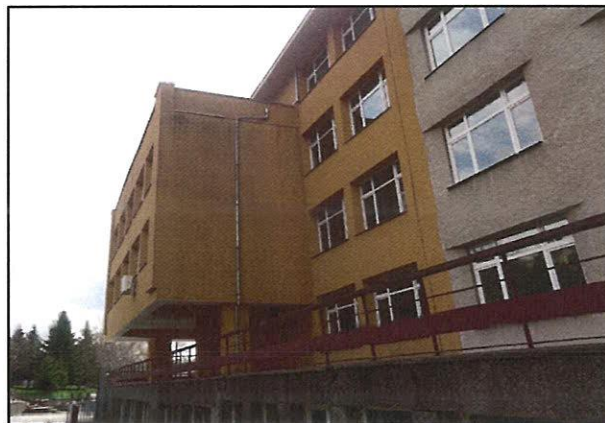
Снимка 8 – Фасадна стена
