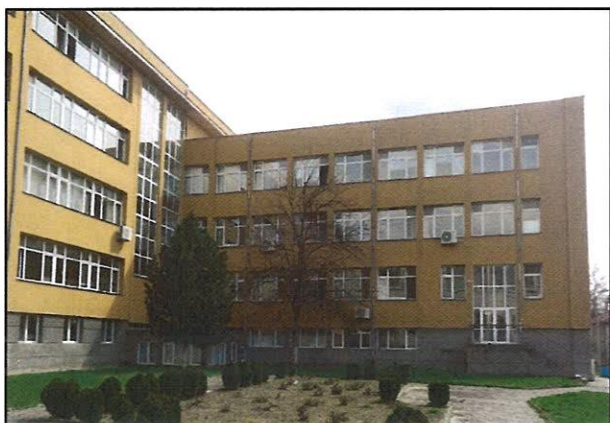
Снимка 5 – Фасадна стена
