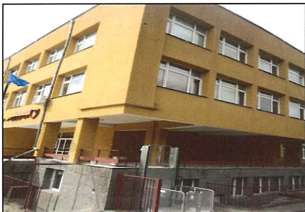
Снимка 7 – Фасадна стена
