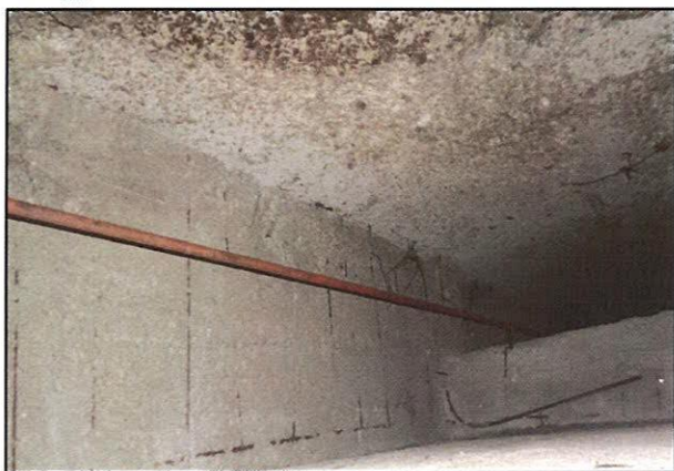
Снимка 119 – Подпокривно пространство
