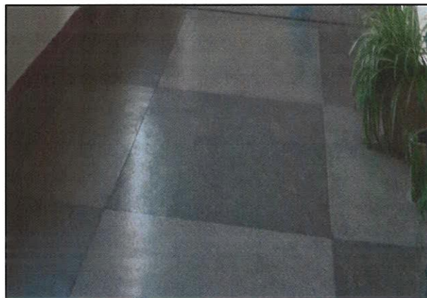
Снимка 32 – Монолитна мозайка по под
