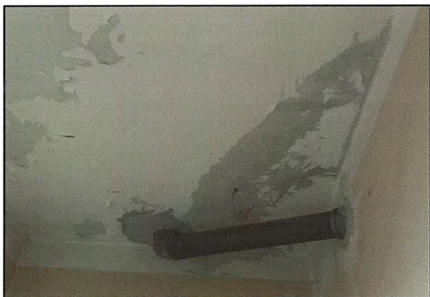
Снимка 79 – Водосточни тръби
