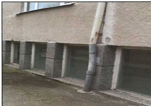
Снимка 80 – Заустване на дъждовните води в сградната канализация
