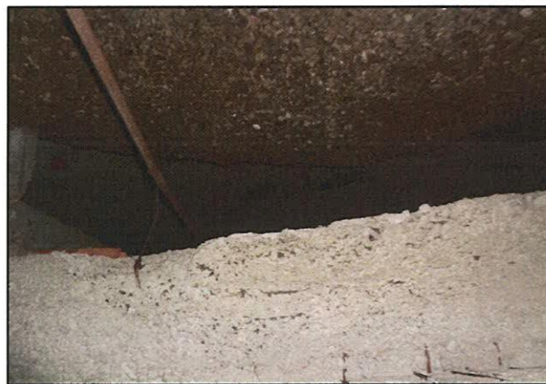
Снимка 120 – Подпокривно пространство
