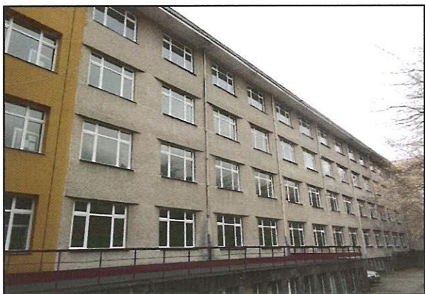
Снимка 1 – Фасадна стена
