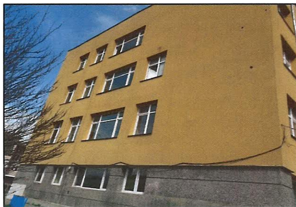
Снимка 6 – Фасадна стена
