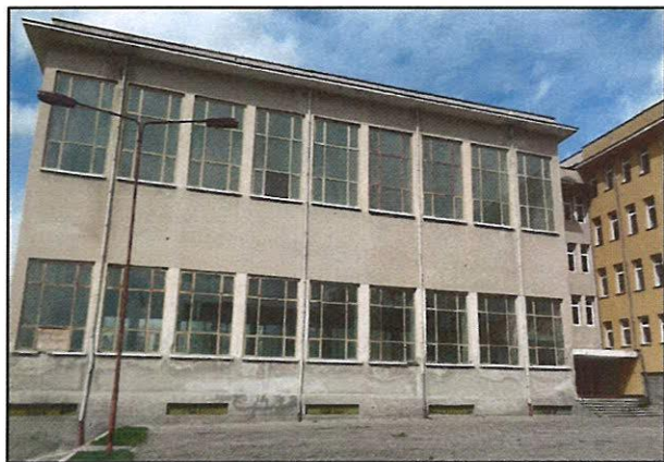
Снимка 3 – Фасадна стена
