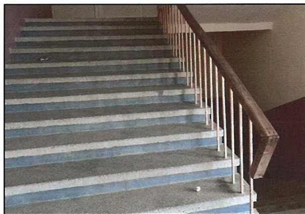
Снимка 30 – Монолитна мозайка по стълбище
