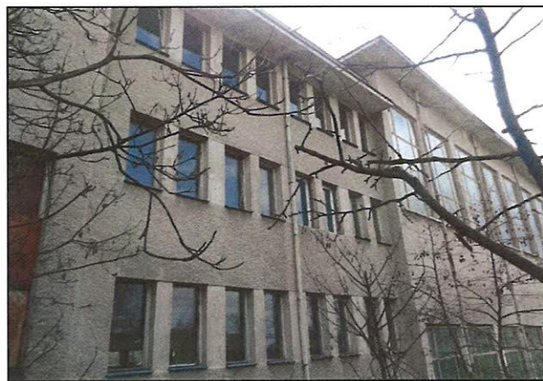
Снимка 2 – Фасадна стена
