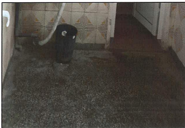
Снимка 31 – Монолитна мозайка в санитарно помещение
