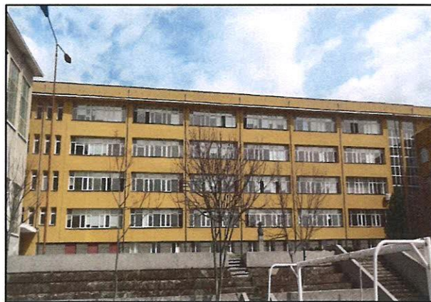
Снимка 4 – Фасадна стена
