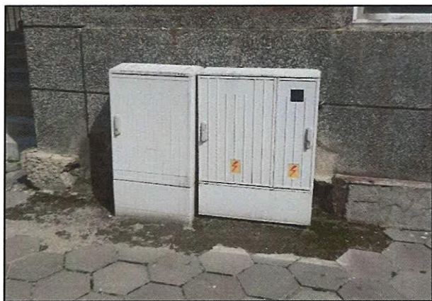
Снимка 81 – Разпределителна касета и електромерно табло
